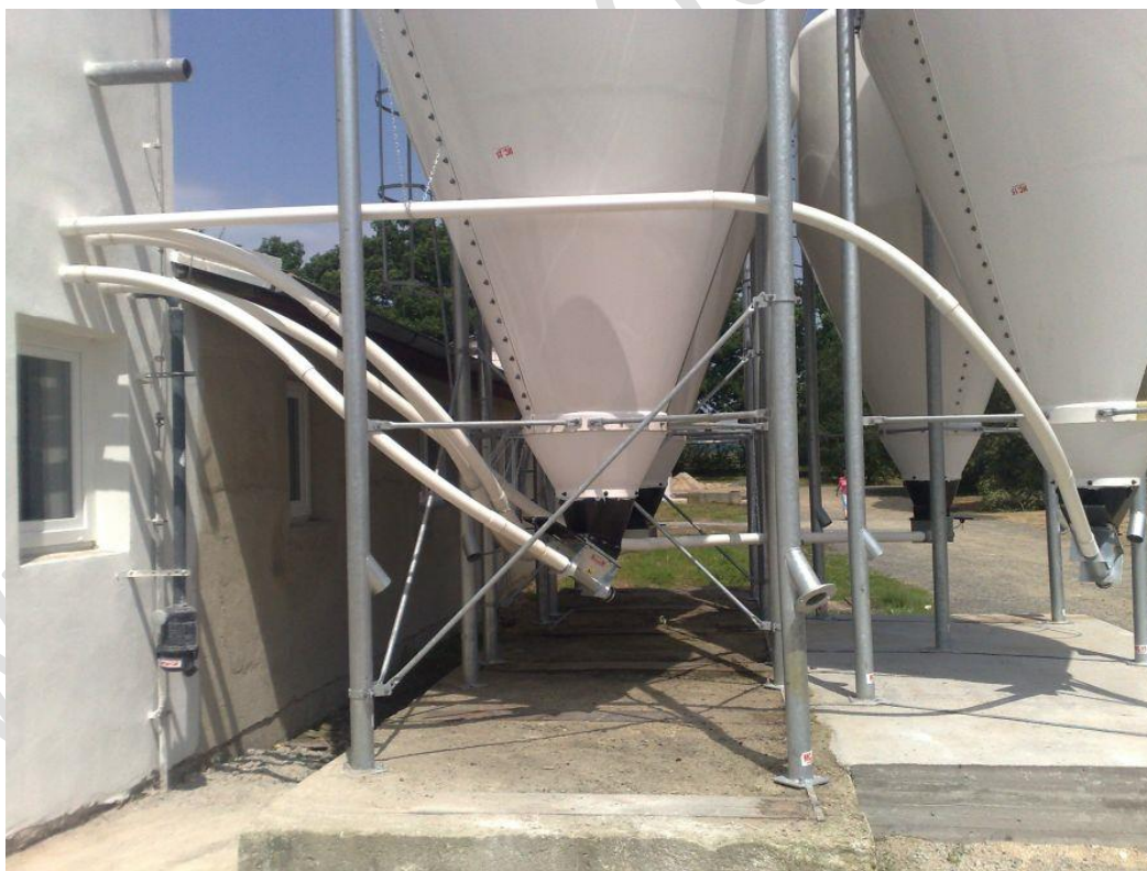
نصب اوگر در قسمت تحتانی سیلو برای انتقال دان به مخازن دانخوری داخل سالن مرغداری
